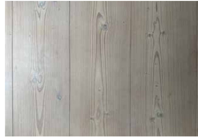
Douglas plankegulve fra Dinesen med gulvarme
