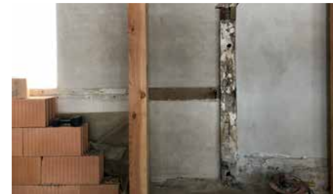
Isolering med teglblokke og træuld. Diffusionsåben facade
