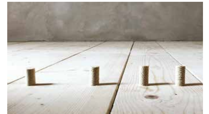
Dyvlede planker på gulv og loft
