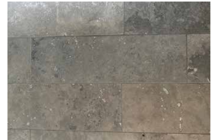
Flisegulve, Kalksandsten fra Østersjosten
